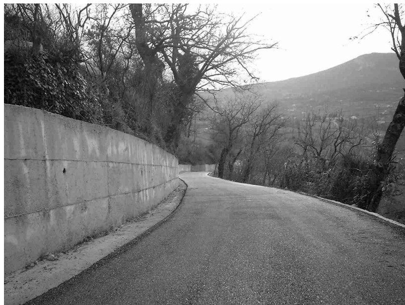
La strada denominata Via Chiusa, della quale sono stati ultimati i lavori di sistemazione
